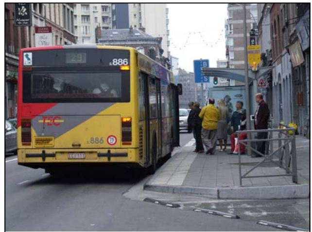
Liège, rue Libotte : la contre-alvéole permet un bon accostage mais peut engendrer des encombrements
