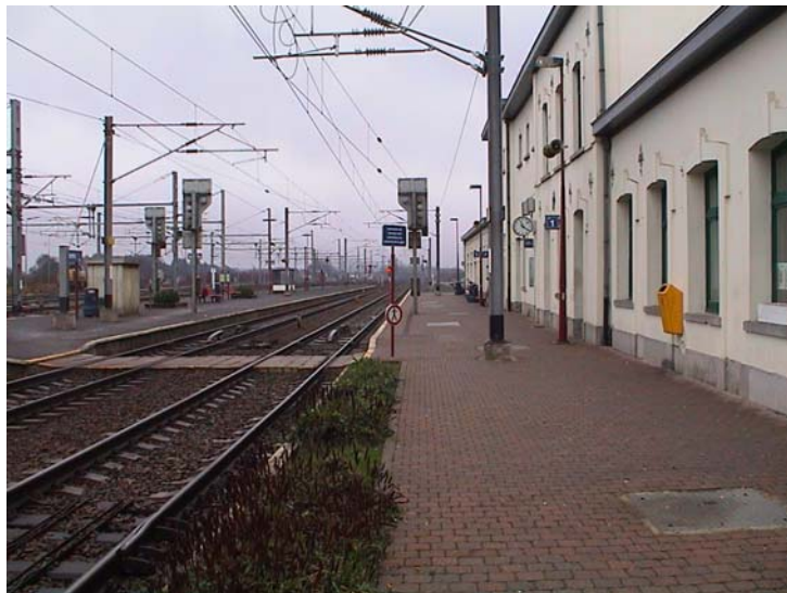
Les quais de la gare de Bertrix : pas de ligne de sécurité, pas de siège sous abri, pas de « tambour horaire » sur le quai 1. L'abri du quai 2 est trop éloigné.
