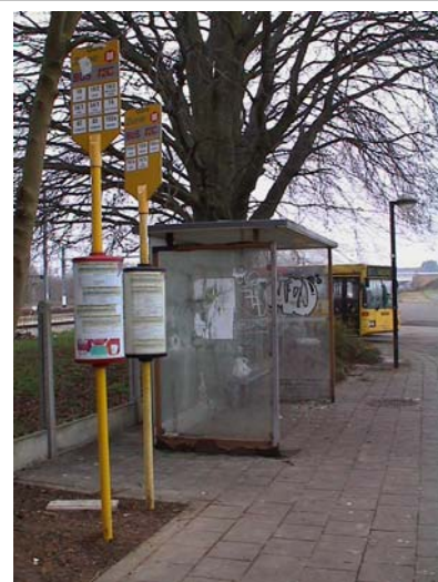
En avant plan, les panneaux TEC placés les uns derrière les autres.
