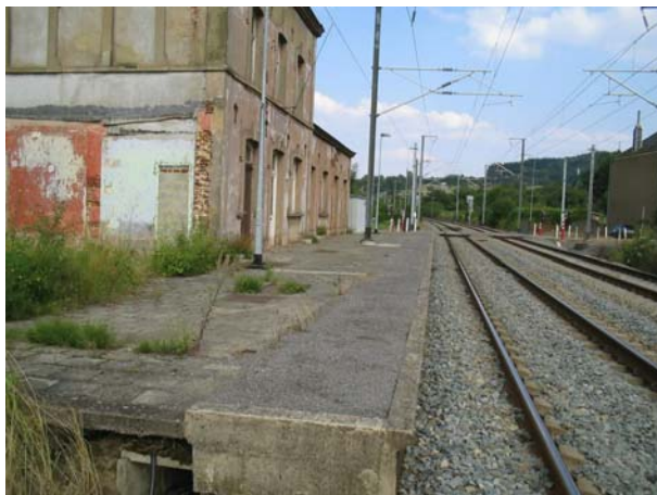
A Halanzy, les travaux de réfection de la voie ont épargné un quai....
