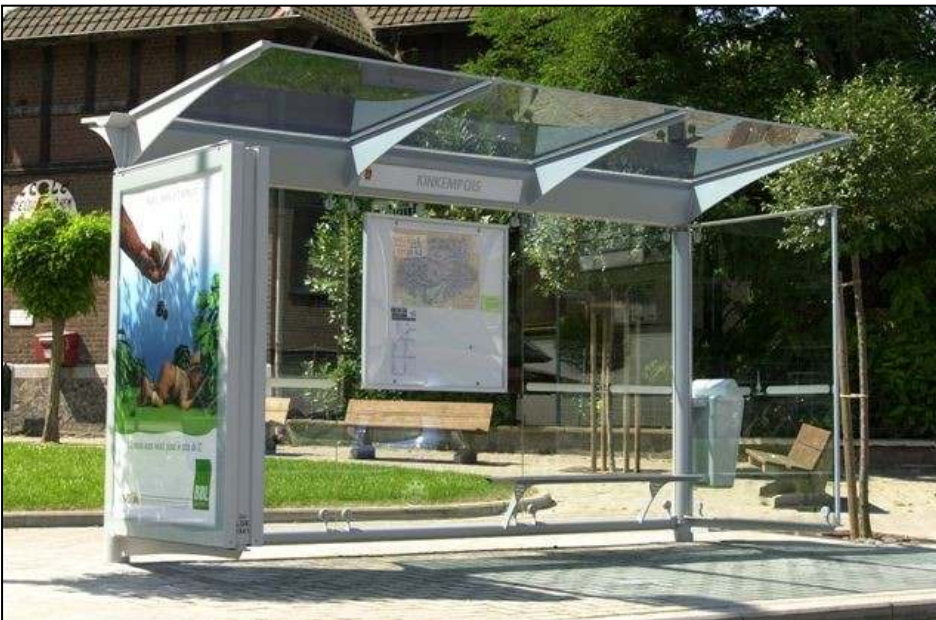
Un modèle esthétique (Decaux) mais qui présente certaines lacunes : toiture laissant s'engouffrer le vent, ouvertures latérales qui assurent une mauvaise protection en cas de pluie oblique.
