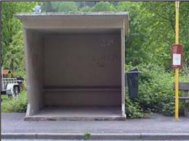
Ce type d'abri est indestructible mais le client, véritablement cloîtré, n'est pas vu et ne voit pas arriver le bus. © ACTP
