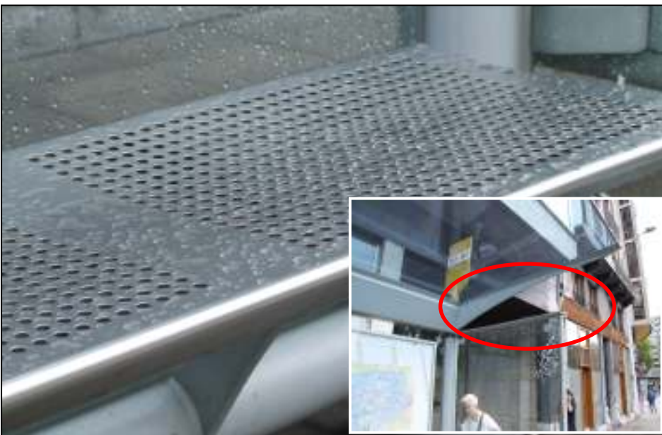
La plupart des abribus JC Decaux présentent des ouvertures latérales qui ne permettent pas une protection efficace contre la pluie oblique et les courants d'air. Bien souvent, le siège est inutilisable en cas d'intempérie.
