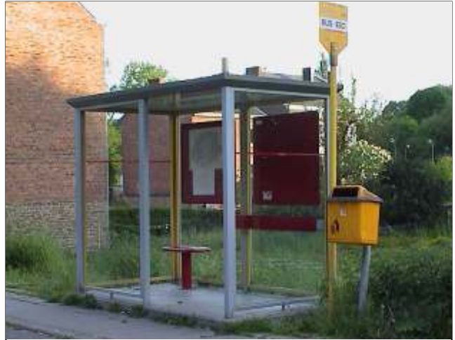
Les abris proposés par la SRWT aux communes sont particulièrement bien conçus : parois vitrées (y compris devant le siège) munies d'une bande de sécurité et dépourvues d'ouverture latérale. © ACTP
