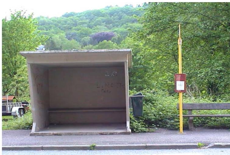
Ce type d'abri est utilisé par les TEC en milieu rural et la SNCB. Très robuste, il offre une bonne protection et un siège pouvant accueillir 4 personnes. Dans le cas des TEC, une ouverture latérale devrait permettre de voir arriver le bus. Il peut difficilement être implanté en milieu urbain.
