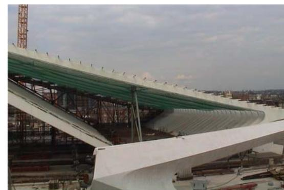
*Vue d'une des deux passerelles donnant accès aux quais à partir du dépose-minute. Le contreventement visible au milieu de la passerelle est provisoire.*
