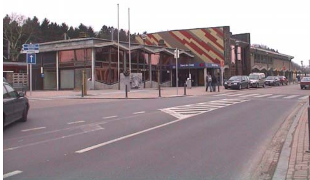
Photo 1 : bâtiment de la gare de Ciney
