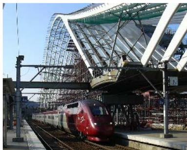
La charpente « Calatrava » de la gare des Guillemins compte maintenant 10 arcs montés. La plateforme de montage est libérée pour permettre le montage de 5 arcs supplémentaires. Une nouvelle poussée (de dix plus cinq arcs) est prévue pour la mi-octobre.
