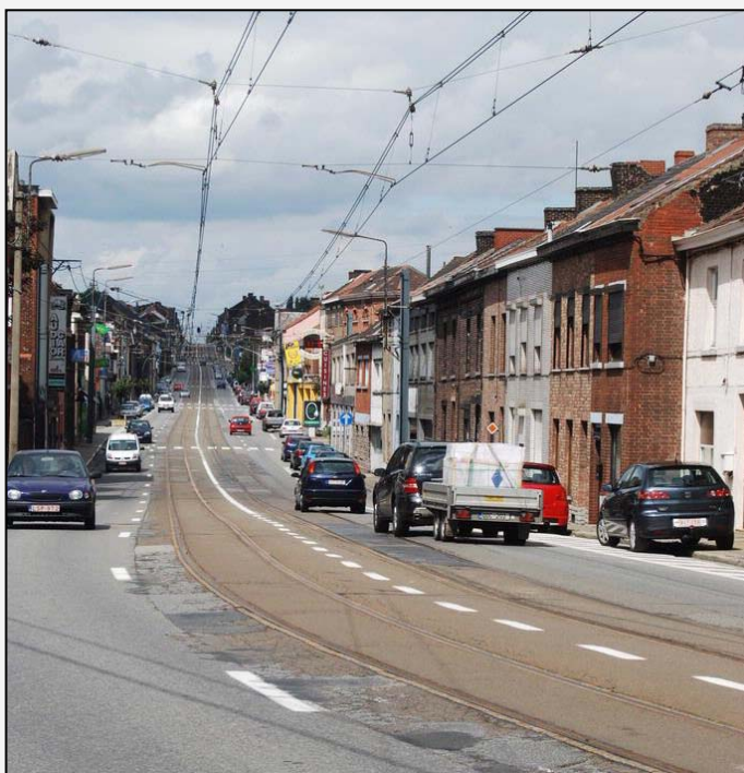
Véritable colonne vertébrale de l'antenne de Gosselies, la chaussée de Bruxelles sera réaménagée en profondeur de façade à façade. Photo : www.charleroi-bouge.be
