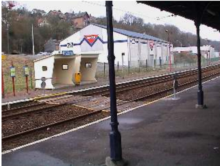
Hamoir: une traversée de voies bien trop dangereuse
