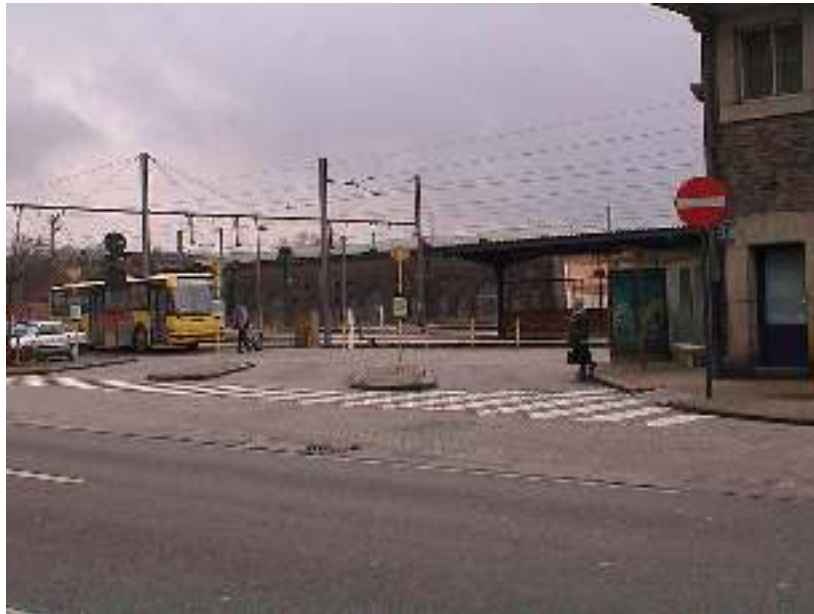
A Jemelle, les gares TEC et SNCB sont côte à côte. Ce n'est malheureusement pas le cas partout sur la ligne 43.
