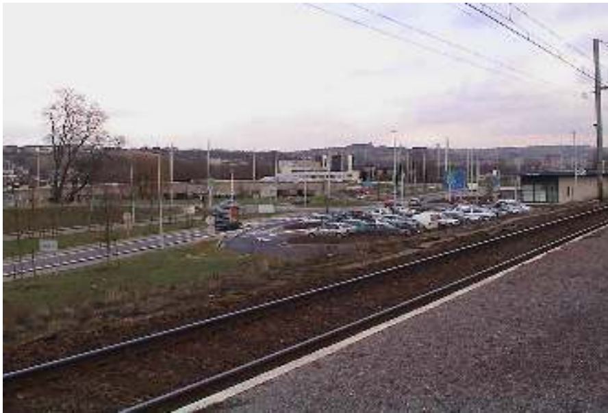
De vastes espaces disponibles permettraient d'accroître la capacité du parking d'Angleur
