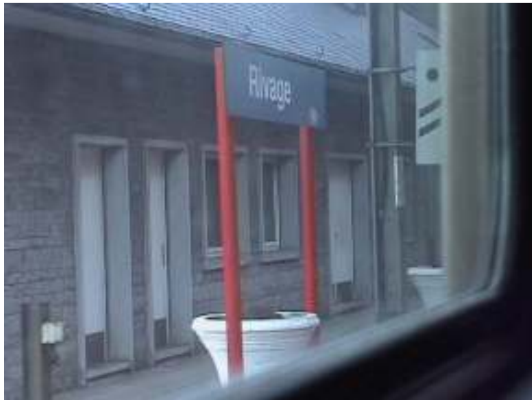
Les panneaux ne sont pas lumineux ; ils sont insuffisamment éclairés ce qui pose un problème de lisibilité
