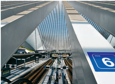
Une belle gare, mais qui n'est pas exempte de critiques. ■ TH. VAN ASS
