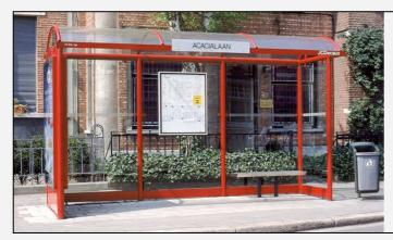
Cet abri dispose de bonnes parois latérales assurant protection une contre les pluies obliques. Le nom de l'arrêt figure bien en évidence et le siège est judicieusement décalé par rapport la valve d'information.
