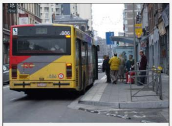
La contre-alvéole permet un bon accostage mais peut engendrer des encombrements (le bus bloquant une bande de circulation).
