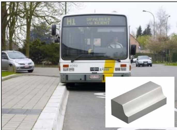
En guidant le bus lors de son accostage, les bordures profilées permettent de réduire les lacunes horizontales et verticales entre le quai et le plancher des véhicules (maximum 50mm). © URBAMAT
