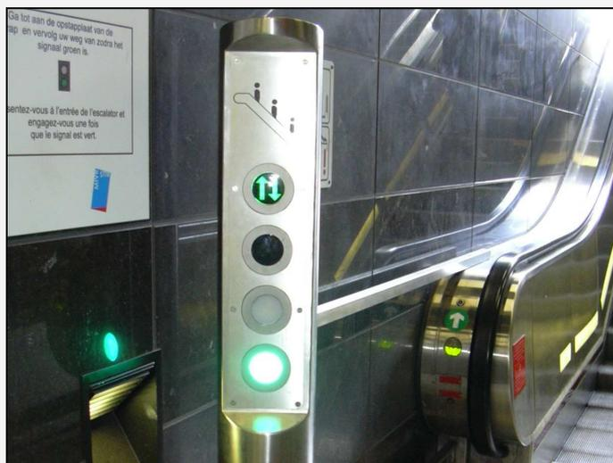
Depuis juin 2005, un escalator réversible fonctionne à la station Eddy Merckx. Cet engin a la particularité d'être utilisable à la montée et à la descente. Il est commandé par un automate programmable qui détecte la présence de personnes désirant l'emprunter.
