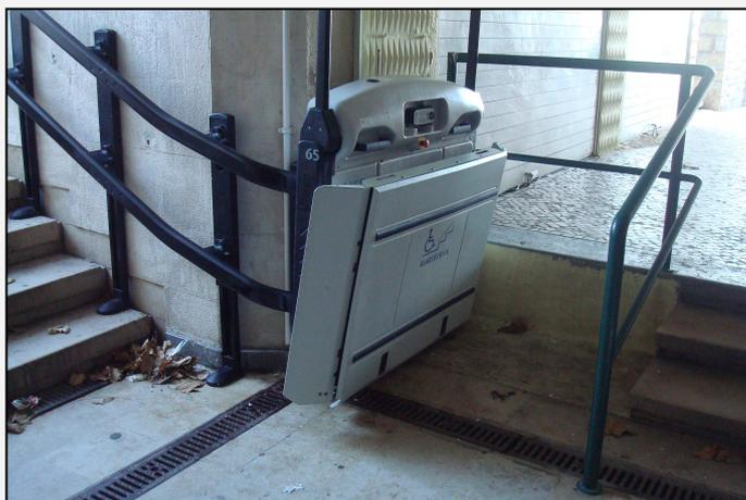
A Estoril (Portugal), l'accessibilité en complète autonomie aux quais et aux convois est garantie pour les PMR grâce à un monte-chaise roulante (utilisable sans assistance contrairement au modèle utilisé par la SNCB) et à un rehaussement des quais.
