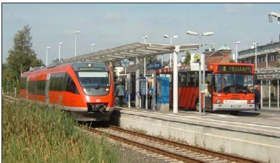
*La connexion train-bus à Stolberg (Allemagne). Un modèle du genre : distance minimale, embarquement de plain-pied, couverture des quais, distributeurs de titres de transport, ...*
