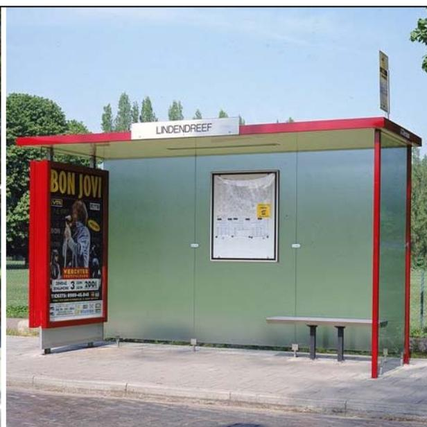
*A gauche : avec ses parois latérales ouvertes, cet abribus n'offre pas une protection suffisante en cas de fortes pluies. En outre, le siège est placé devant le panneau d'information.*
