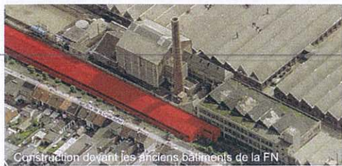
Construction devant les anciens bâtiments de la FN
